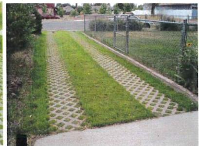
Structure béton alvéolé avec bande de roulement
